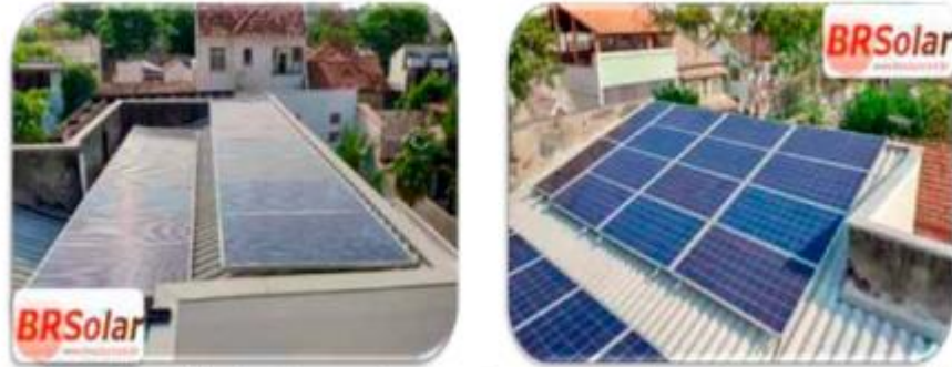
Foto 1 e 2 Sistema Fotovoltaico de microgeração para auto consumo local e remoto gerando em sua residência o consumidor gera excedente para abastecer seu consultório em outro endereço dentro da área da mesma concessionária.
